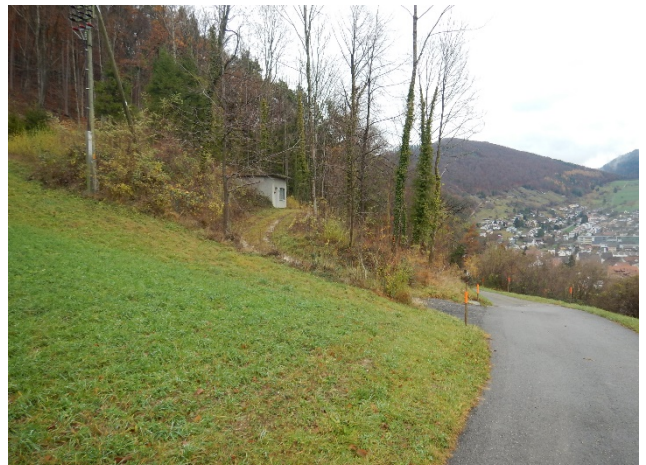
Reservoir Thommeten, WV Oberdorf
