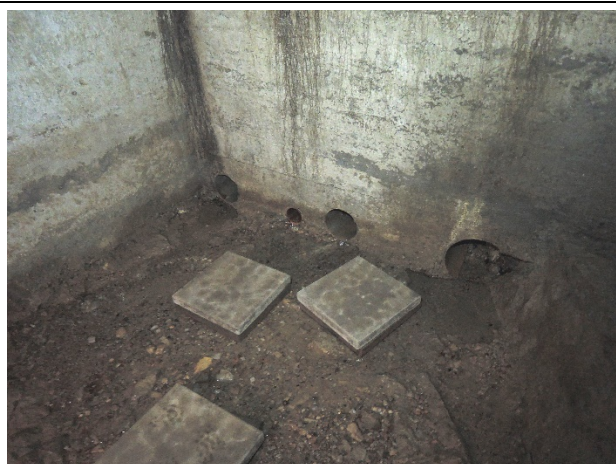
Quelle z'Hof Niederdorf – Einläufe A, B, C, D
