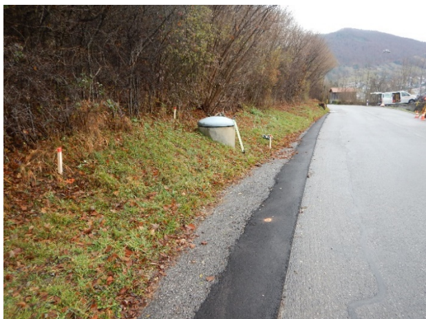
Quelle z'Hof Niederdorf – Umgebung vor Sanierung Kantonsstrasse, abgesteckt sind die Umrisse der unterirdischen Brunnstube
