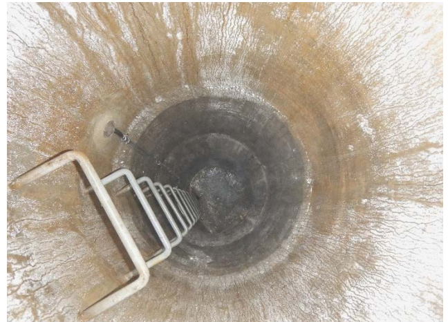
Quelle z'Hof Oberdorf Nord (Ost) - Einstieg
