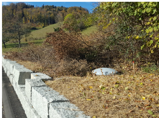
Quelle z'Hof Niederdorf – Umgebung nach Sanierung Kantonsstrasse
