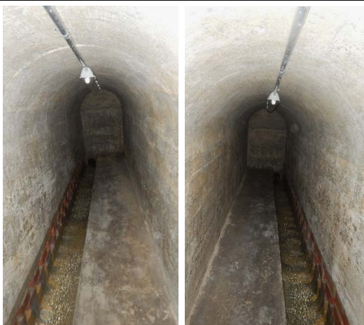
Quelle z'Hof Oberdorf West – Sickerstollen →E, Sickerstollen →W
